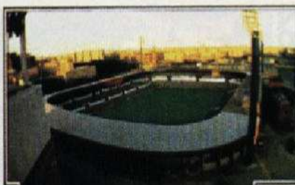
ZARAGOZA - Estadio La Romareda
